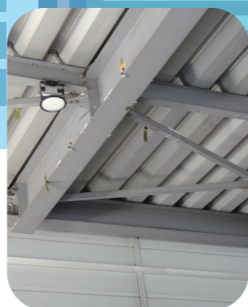
埼玉/ハト 食品倉庫
