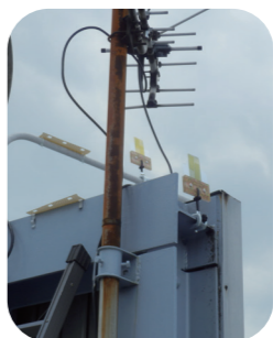
東京/カラス オフィスビル
